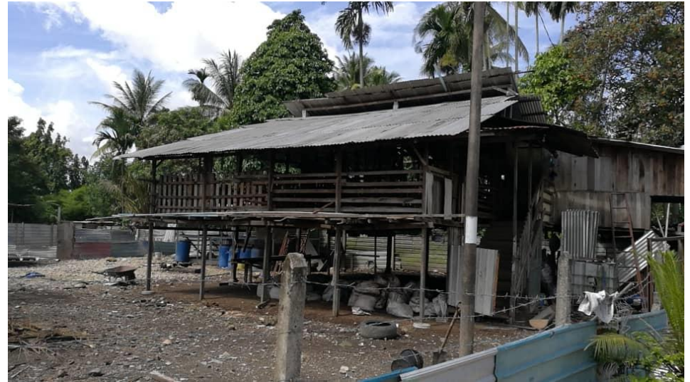
Tapak yang akan dinaiktaraf kandang kambing baru.
